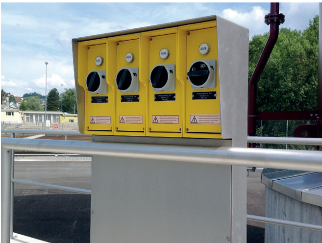
Vor-Ort-Schalter in Gehäuse 2812 gelb, ARA Herisau
