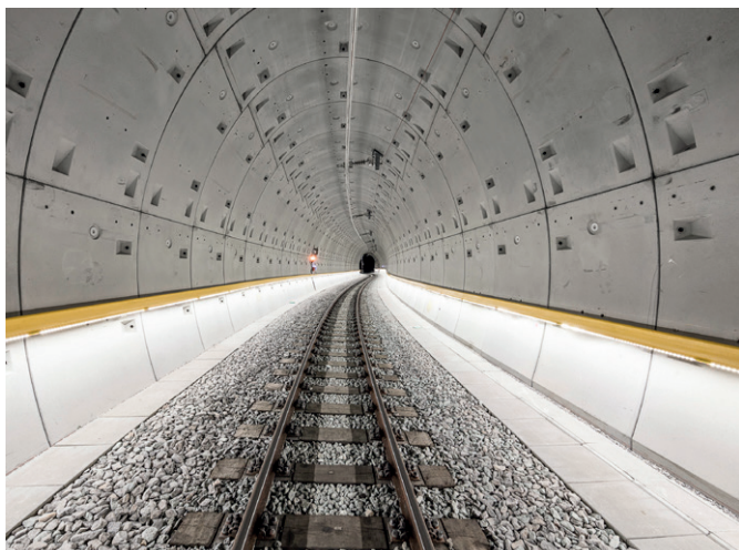
LaneLED GFK, Tunnel Glatscheras
